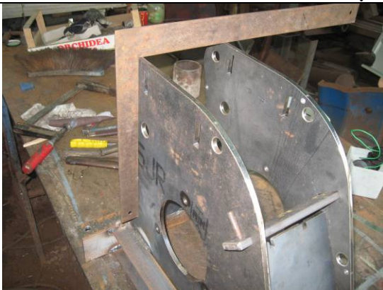
Equerrage du bâti de la JLAKit
